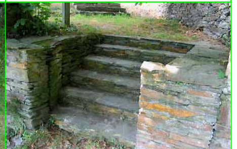
stairs to NAVE escaleras hacia la NAVE
