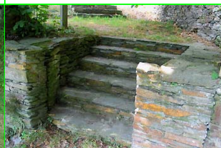
stairs to NAVE escaleras hacia la NAVE
